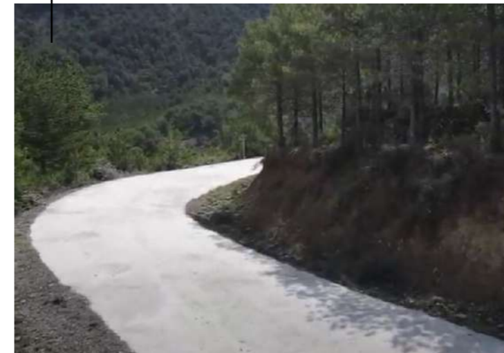
Arreglo de la pista de acceso
