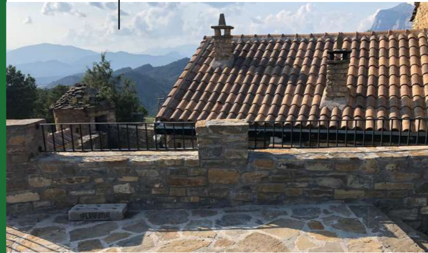
Instalación de barandillas metálicas
