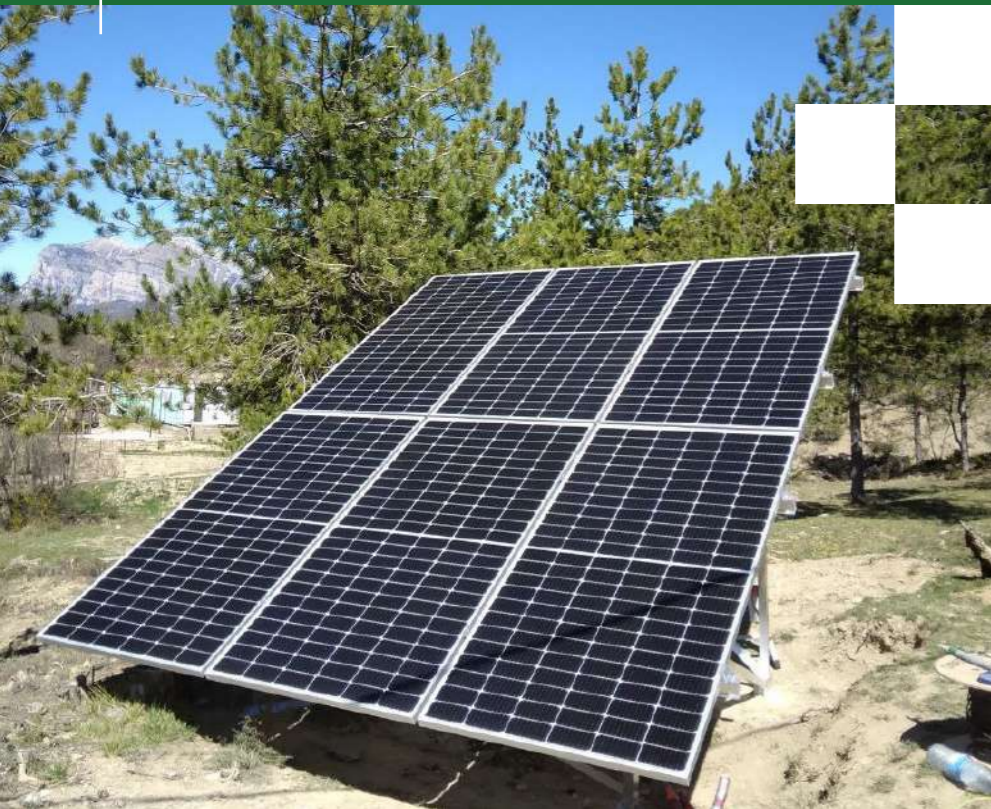
Instalación placas solares
